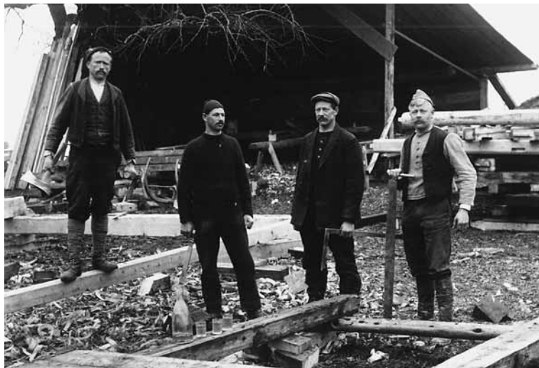
Sie waren auf Sägereien angewiesen: Zimmerleute beim Abbinden der Balken einer Scheune.
