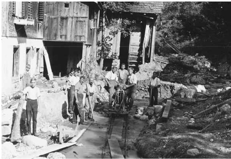
Beim Unwetter von 1934 wurde auch Karl Nuss- baumers Sägerei beschädigt.
