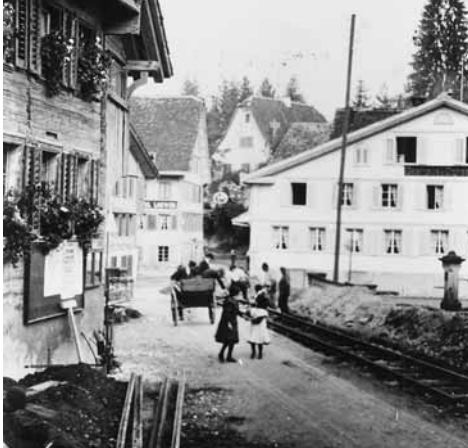
Die Schienen der ESZ werden verlegt.
